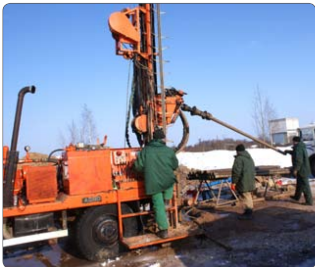
Pav. 2. Naujos AE potencialiose statybos aikštelėse vykstantys lauko darbai.
