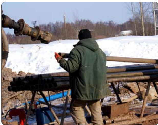
Pav. 3. Naujos AE potencialiose statybos aikštelėse vykstantys lauko darbai.
